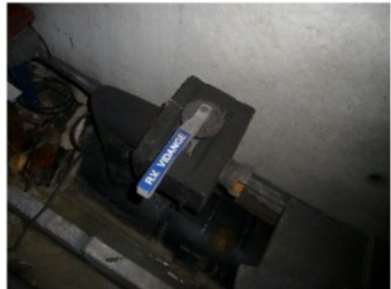
142m du P.I. 0496 : Robinet vanne de vidange
